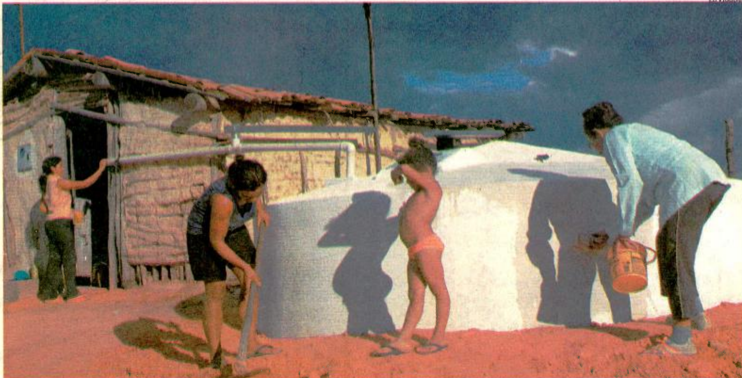
As pedreiras de Limoeiro ganham em média R$ 200,00 por cisterna, que armazena 16 mil litros, suficientes para abastecer uma família por seis meses
